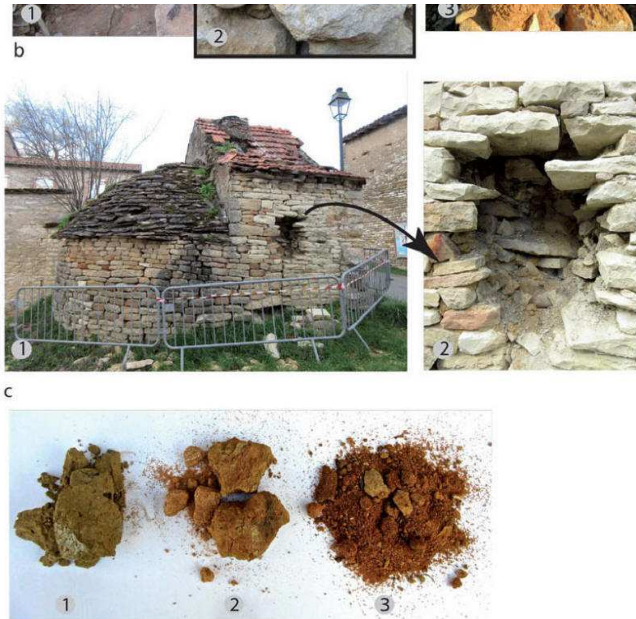
Fig.2 : Quelques exemples de murs des coteaux du Mâconnais près de Tournus (71) jointoyés à la terre.
