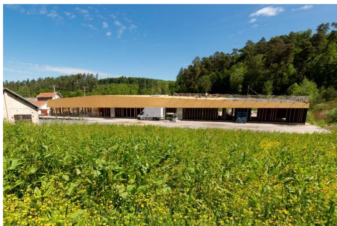
Figure 22. Atelier bois de l'ONF où le hêtre est mise en œuvre non traité en intérieure pour la structure portique lamibois, les parquets et les menuiseries, et traité en extérieur pour le bardage, Xertigny et Hadol (Terres de hêtre, nd)
