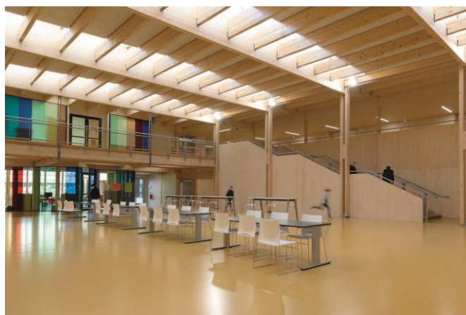
Figure 32. Poutres reconstituées en sapin massif bloquées avec des clavettes en hêtre pour la reconstruction du collège Elsa Triolet à Thion-les-Vosges (Cartignies-Canonica, 2019 ; Cartignies-Canonica, S. Mangin, nd)
