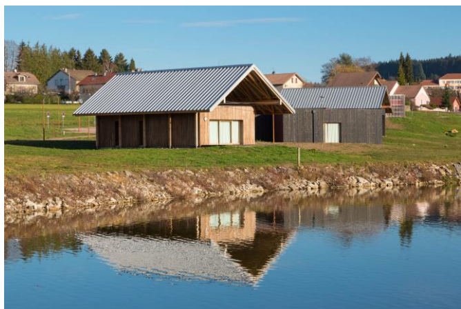
Figure 26. Woodies à Xertigny (88) : six modules d'habitat léger de loisir avec différentes techniques constructives en hêtre (Hamard, nd)
