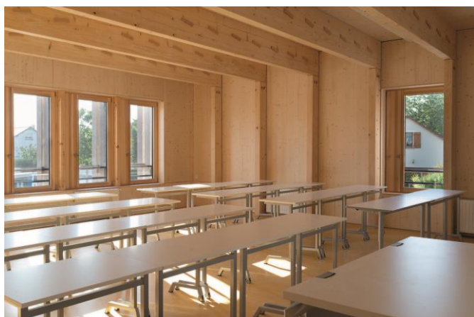
Figure 32. Poutres reconstituées en sapin massif bloquées avec des clavettes en hêtre pour la reconstruction du collège Elsa Triolet à Thion-les-Vosges (Cartignies-Canonica, 2019 ; Cartignies-Canonica, S. Mangin, nd)
