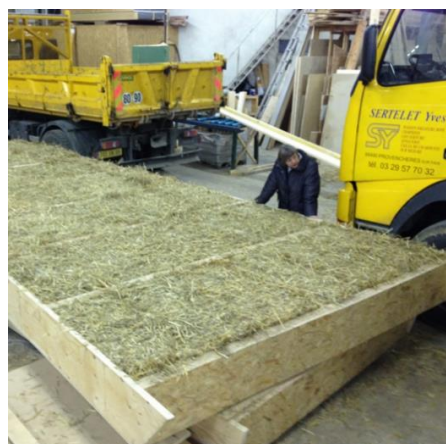
Figure 20. Processus de construction, fabrication et pose de l'ossature en caissons de hêtre (Haha atelier d'architecture, nd)
