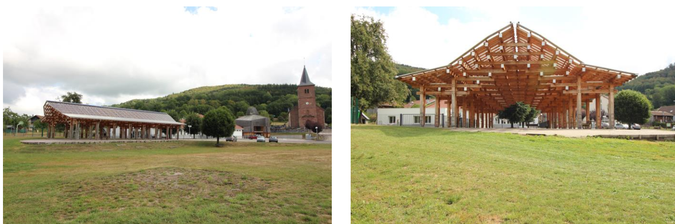
Figure 21. Halle polyvalente de Tendon (88) avec une structure empilée et moisée en douglas (Mazel, 2020)
