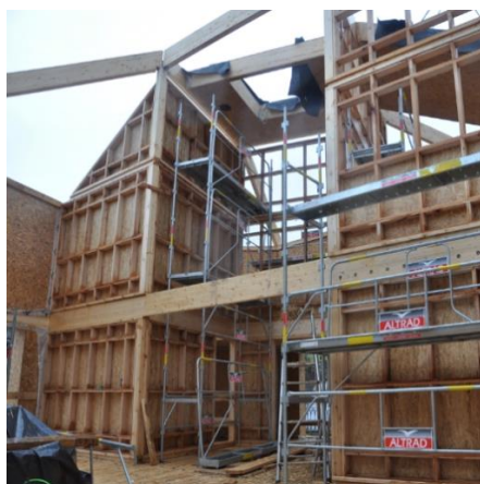
Figure 20. Processus de construction, fabrication et pose de l'ossature en caissons de hêtre (Haha atelier d'architecture, nd)
