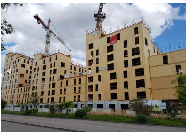
Figure 10. Immeuble Sensations dans l'Îlot bois à Strasbourg, construit avec des panneaux de l'entreprise KLH en provenance d'Autriche (Mazel, 2020, Lignatec, nd)
