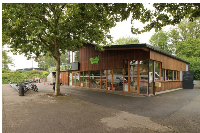
Figure 24. Maison du vélo du port d'Épinal où le hêtre est utilisé autant pour la structure que pour les finitions intérieures (Mazel, 2020)
