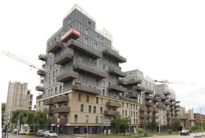
Figure 10. Immeuble Sensations dans l'Îlot bois à Strasbourg, construit avec des panneaux de l'entreprise KLH en provenance d'Autriche (Mazel, 2020, Lignatec, nd)
