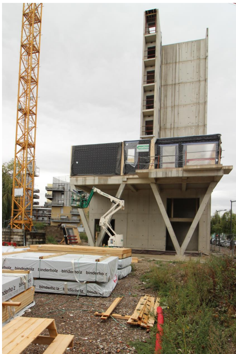
Figure 9. Opération L'Orée de deux rives dans l'Îlot bois à Strasbourg, réalisée avec des panneaux CLT livrés depuis les sites allemands ou autrichiens de l'entreprise Binderholz (Mazel, 2020)
