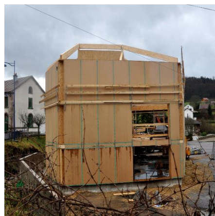
Figure 20. Processus de construction, fabrication et pose de l'ossature en caissons de hêtre (Haha atelier d'architecture, nd)
