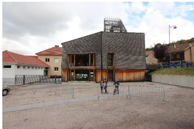
Figure 17. Façade de tavaillons en mélèze et finitions intérieures en hêtre massif (I. Mazel, 2020 ; Haha atelier d'architecture, nd)
