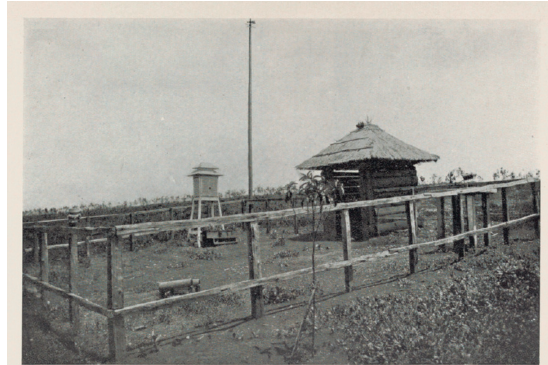
Station expérimentale du Quinquina, de Lang-Hanh (province du Haut-Donnai, Annam). La station climatologique : à gauche, le psychromètre et les thermomètres sous abris pour la température de l'air près de la surface du sol ; au fond, l'abri météorologique et la girouette sur son mât ; à droite, l'héliographe sur sa table en ciment. La station est entourée d'une forte palissade empêchant l'accès du bétail et des animaux sauvages (cerfs, etc.) ; à la porte est une cabane pouvant servir d'abri à l'observateur.
