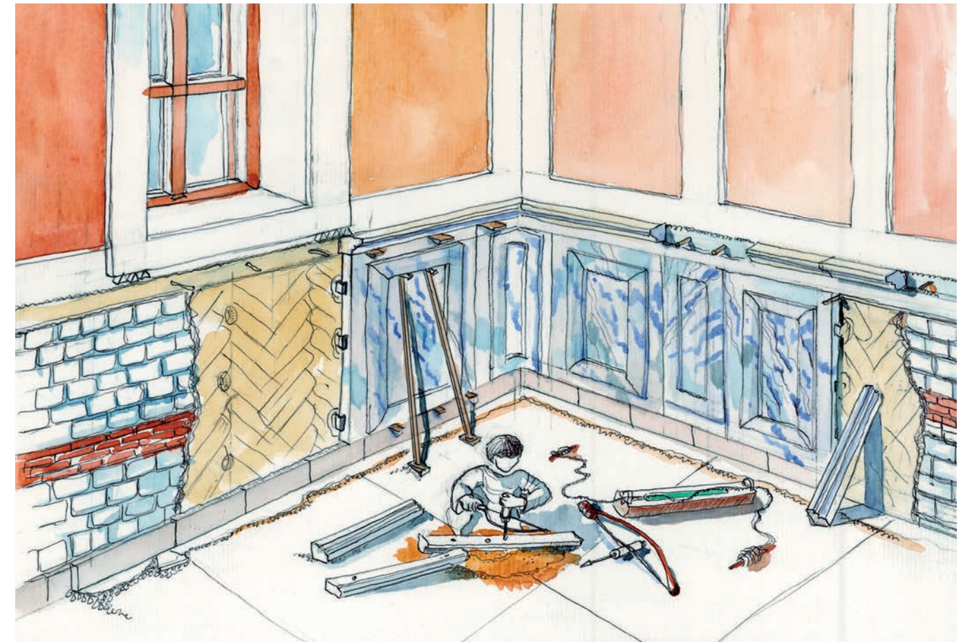
▲ Scène de mise en œuvre de placages de marbres avec un foret à archet. Aquarelle J.-M. Gassend.
