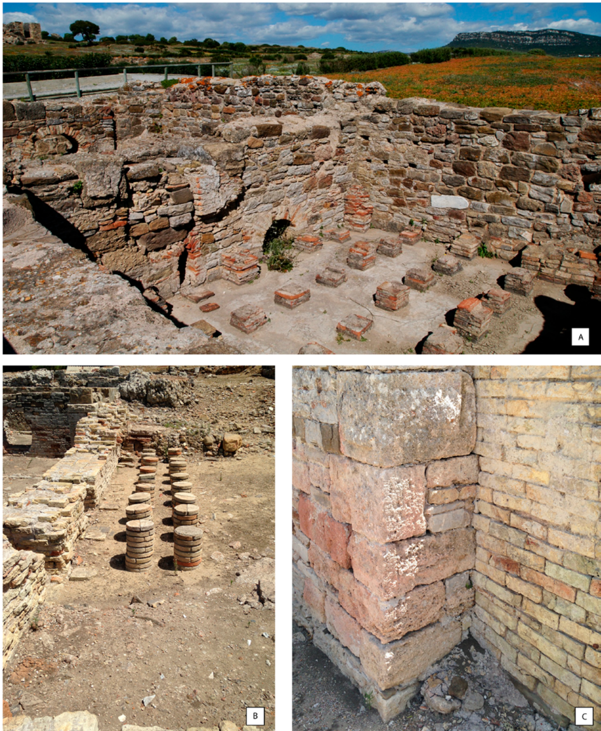
Fig. 24 : Empleo de material latericio en los edificios termales de Baelo y Carteia (HAR2015-64392-C4-1-P).
