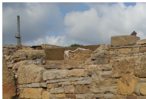
Fig. 14 : Muro de la basílica de Carteia en opus uittatum con sillares de calcarenita (HAR2015-64392-C4-1-P).
