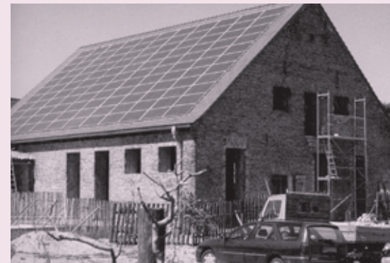
Équipement en panneaux solaires d'une vieille grange dans la communauté de Klein Jadesow dans le Pommerland (Allemagne), 2005 (photo: www.kleinjasedow-familie.de ). Dans le scénario Green tech , l'essor de l'énergie photovoltaïque s'accélère à mesure que des technologies nouvelles et plus efficaces deviennent disponibles, mais la croissance est contrainte par les goulots d'étranglement de la production et par l'excès de la demande, de sorte que la part du solaire dans la production énergétique totale reste mineure.
