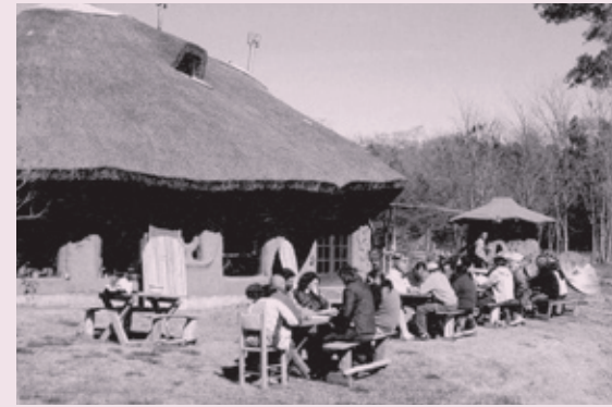
Bâtiment communautaire dans l'écovillage de Gaia à Navero (Argentine), avec toit en chaume, murs en pisé et conception en solaire passif, 2007. Dans le scénario des canots de sauvetage, les communautés volontaires existantes en milieu rural, avec des équipements et une économie partagés, pourraient être les mieux à même de conserver une gouvernance collective aussi bien que des chaînes de transmission de l'information et des compétences en matière de méthodes de construction low-tech, de production de nourriture et d'entretien de la santé.
