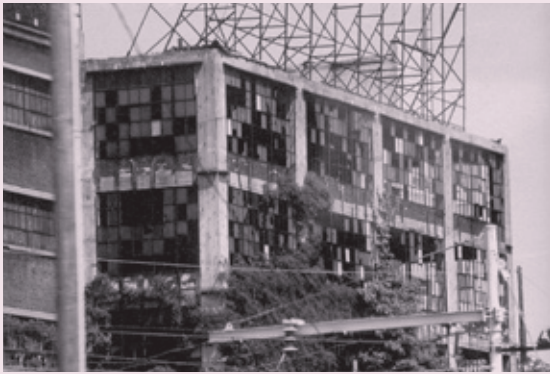
Usines abandonnées à Philadelphie, 2005. Dans le scénario des canots de sauvetage, les bâtiments en ruine fournissent des matériaux de récupération que l'on échange dans des conditions difficiles (à cause du manque de sécurité) dans les zones rurales et périurbaines, contre de la nourriture et d'autres biens de première nécessité.
