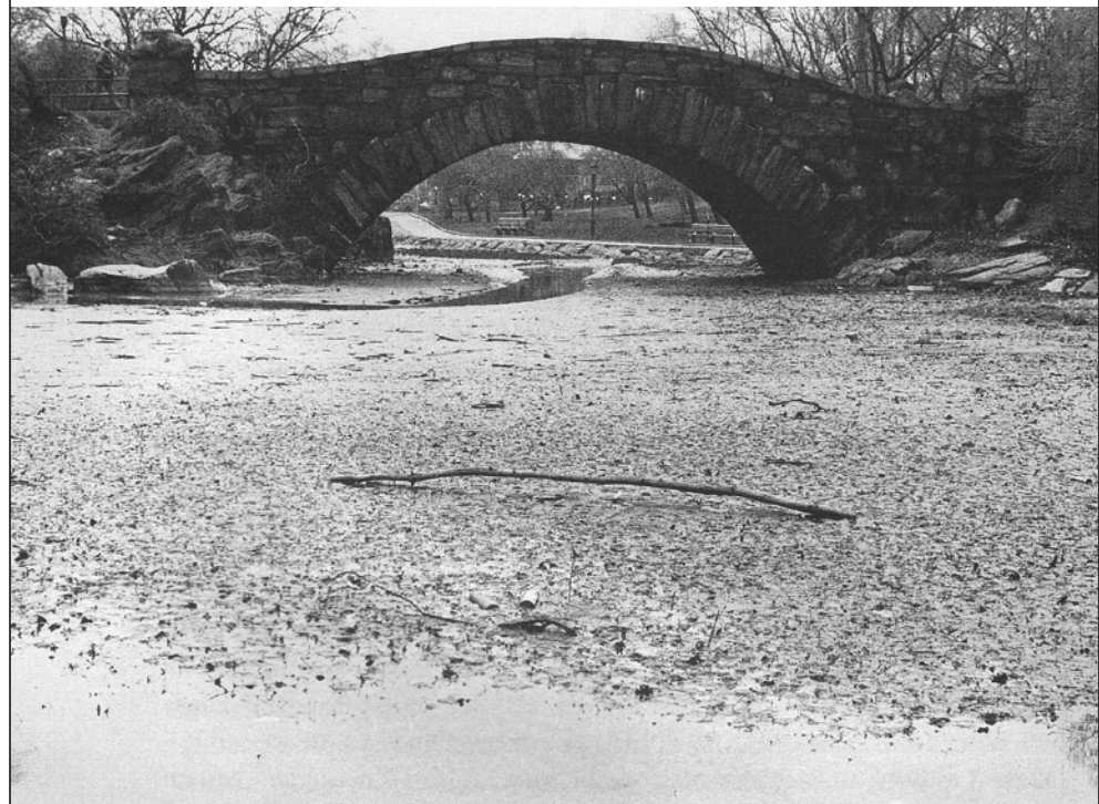
Le pont de Gapstow au-dessus du Pond envasé.
