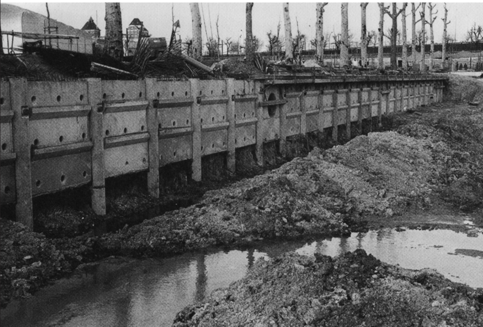
Le «mur à la parisienne» en cours de coffrage (in ibid. , p.26).
