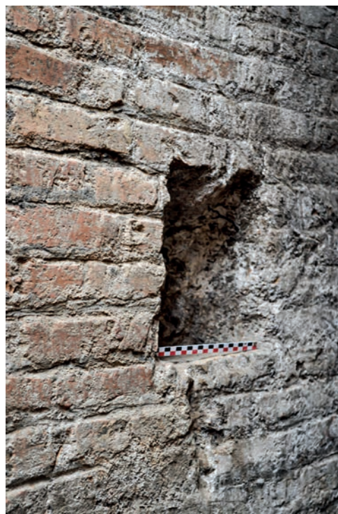
Fig. 296 – L'une des cavités du premier type pratiquée dans le tronçon du mur annulaire A n° 1 a.
