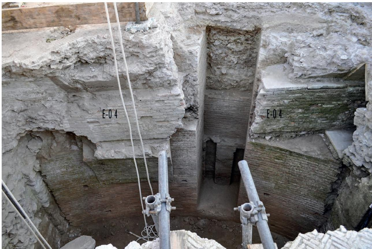
Fig. 53 – Sur cette vue, les deux tronçons restés en place de l'égout E-O 4 prennent appui sur les maçonneries néroniennes qui ont été entaillées dans ce but (vue vers le nord).
