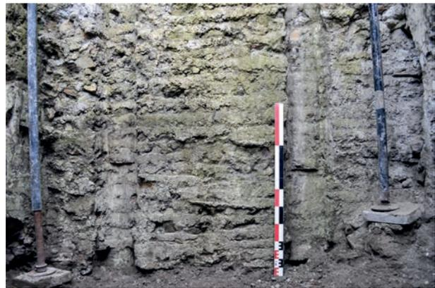
Fig. 75 – Les empreintes du coffrage de bois, révèlent, du fait de leur irrégularité, les difficultés rencontrées pour boiser la tranchée destinée à l'égout n° 125 sur un tronçon correspondant à un affaissement.
