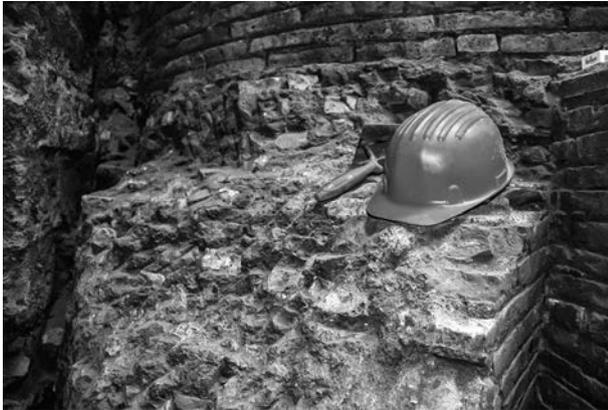
Fig. 14 – L'arc n° 37 a été entamé de la même manière que celui de la figure précédente lors du creusement de la tranchée de la fondation n° 51.
