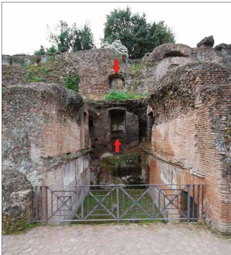
Fig. 14 – L’installation du stylobate du portique nord du complexe sévérien, derrière le mur contenant le terre-plein, certainement sur toute la hauteur de celui-ci, a condamné les portes (flèches) donnant accès à des salles des soutènements installées dans l’angle nord-ouest de la terrasse. Au premier plan apparaît la fondation de la façade, que la Soprintendenza a fait revêtir d’une couche protectrice de moellons de tuf
