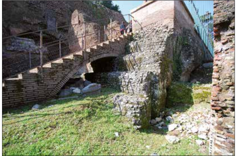
Fig. 7 – La fondation de la façade, qui suit l'inclinaison du terrain, dessine une série de gradins correspondant à des tronçons dont les sommets sont à des altitudes différentes. C'est ici, à la jonction des deux sous-ensembles distingués à l'intérieur des soutènements, que la dénivellation est la plus importante et elle a imposé la création de plusieurs ressauts correspondant à autant d'assises de blocs du mur
