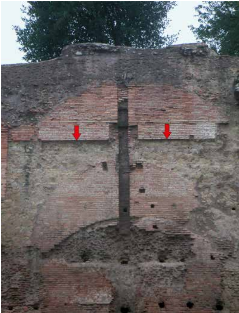
Fig. 5 – Travée basse orientale : les flèches rouges indiquent le niveau de l'extrados de la voûte flavienne. Au centre, logement destiné à un drain vertical d'évacuation des eaux de pluie, qui sera prolongé vers le haut au II e siècle
