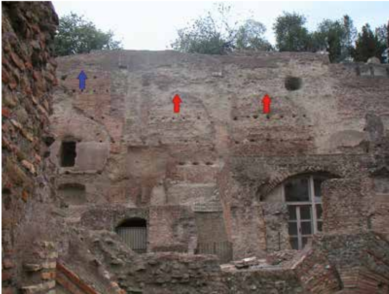
Fig. 4 – Secteur du mur du fond des soutènements ouest sur lequel est visible, à gauche, l'une des cinq travées hautes (flèche bleue), à droite de laquelle ont été repérées les traces de deux travées basses (flèches rouges)
