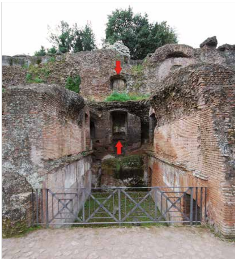
Fig. 14 – L’installation du stylobate du portique nord du complexe sévérien, derrière le mur contenant le terre-plein, certainement sur toute la hauteur de celui-ci, a condamné les portes (flèches) donnant accès à des salles des soutènements installées dans l’angle nord-ouest de la terrasse. Au premier plan apparaît la fondation de la façade, que la Soprintendenza a fait revêtir d’une couche protectrice de moellons de tuf
