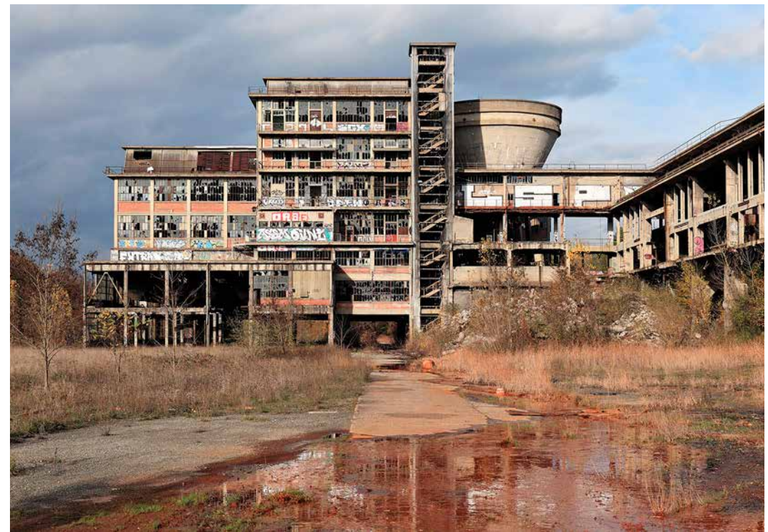
La friche industrielle de l'ancien lavoir à charbon de la Tronquié à Blaye-les-Mines (Tarn) a connu plusieurs incendies. © Photo Sébastien Berrut.
