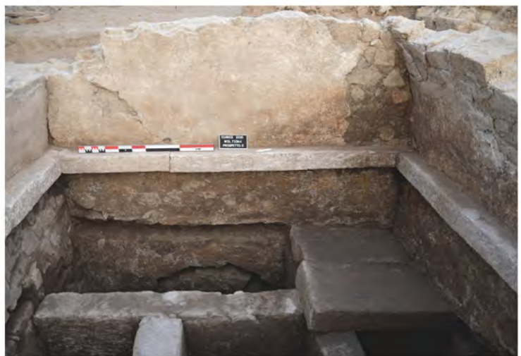
Fig. 5. Vues de l'extérieur et de l'intérieur du mausolée MSL73344 (© Archives CJB, CNRS-EFR).
