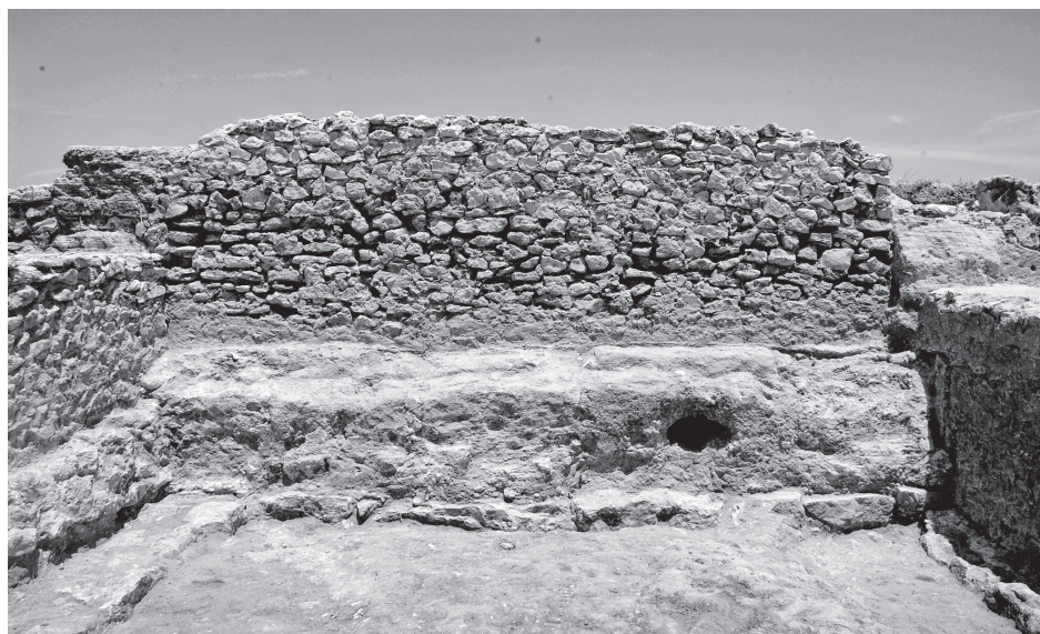
Fig. 5 — Mur nord de la salle 4. Du bas vers le haut apparaissent : la fondation faite de moellons de calcaire, en léger ressaut par rapport à une assise de blocs de grès, sur laquelle prend appui l'élévation appartenant au type 2A. Ce dernier associe un blocage fait de petits moellons de calcaire liés par du mortier de chaux et des harpes montées en bloc de grès, contre lesquelles prennent appui les refends (cl. 572).
