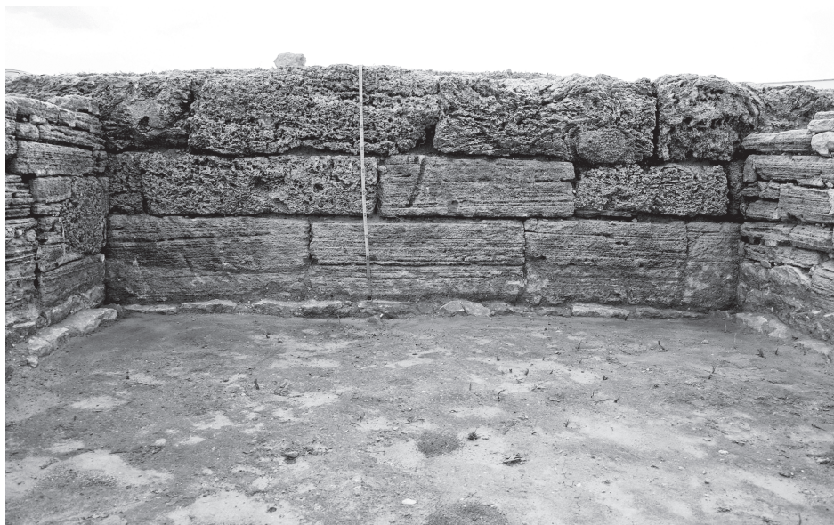
Fig. 6 — Tronçon du mur sud de l'entrepôt monté en grand appareil de grès (type 1) et reposant sur une fondation réalisée au moyen de moellons de calcaire (cl. 8892).
