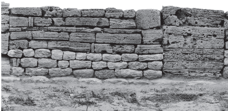
Fig. 7 — Tronçon d'un mur de refend de l'aile méridionale monté en opus africanum du type 3A. Les harpes sont faites de blocs de grès et les moellons de grès ou de calcaire blanc (détail redressement mur 9, V. Dumas).
