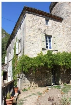
Fig. 41 - Vue de l'élévation sud du corps de logis, adossée à la tour ronde.
