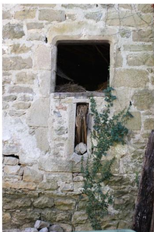
Fig. 58 - Elévation nord du bâtiment agricole, baie couverte d'un arc en accolade et encadrement chanfreiné.
