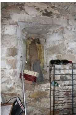
Fig. 22 - Tour ronde, baie du rez-de-chaussée.
