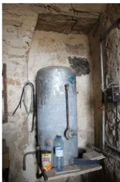
Fig. 23 - Tour ronde, rez-de-chaussée, ancien passage maintenant obturé.
