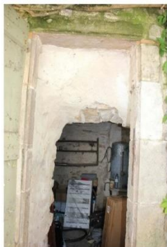
Fig. 40 - Entrée pratiquée à posteriori pour accéder au rez-de-chaussée de la tour ronde.
