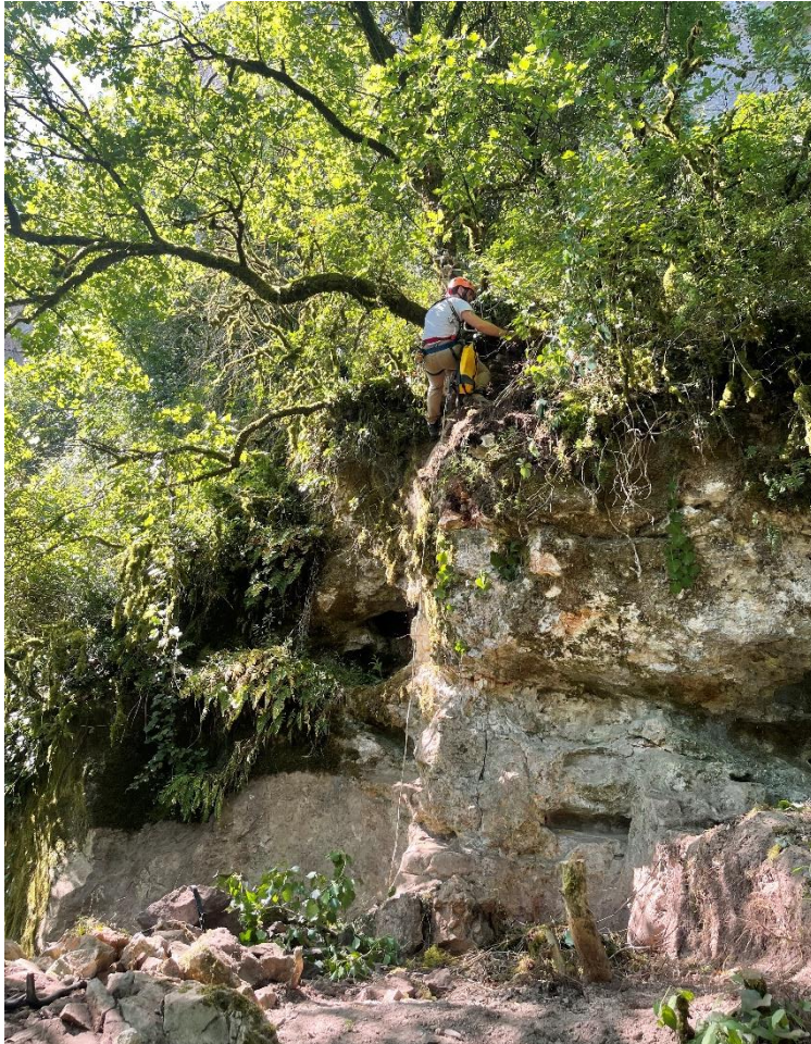
Fig. 1. Purgé de la falaise sur corde avant et pendant la fouille. Crédit F. Guillot
