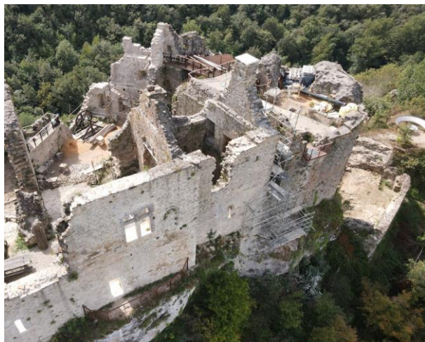
Fig. Mur de réparation en sous-œuvre, découvert sous l'enceinte et la tour à éperon. Crédit F. Guillot
