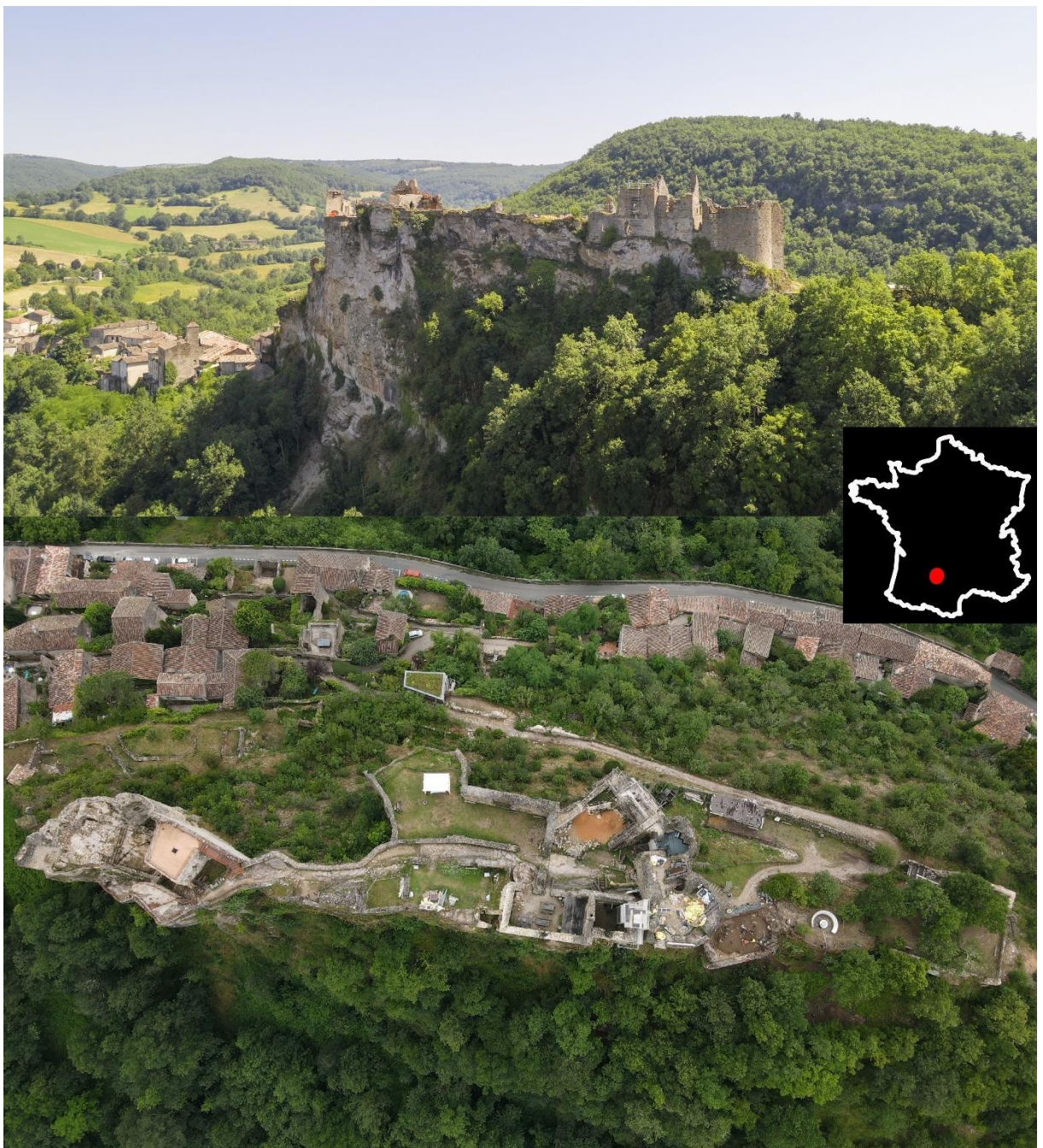
(fig. 1) Vue depuis le nord et le dessus du château de Penne. Cl. D. Langlois et F. Guillot.
