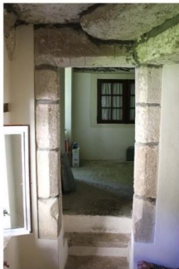
Fig. 32 - Porte extérieure de la tour ronde.
