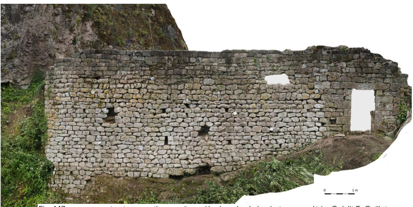
Fig. M7 en parement externe, orthomosaïque développée de la photogrammétrie. Crédit F. Guillot
