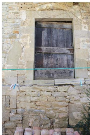
Fig. 59 - Elévation nord du bâtiment agricole, tracé partiel d'un arc.
