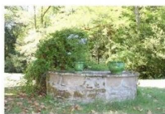
Fig. 50 - Puits à l'est du logis.
