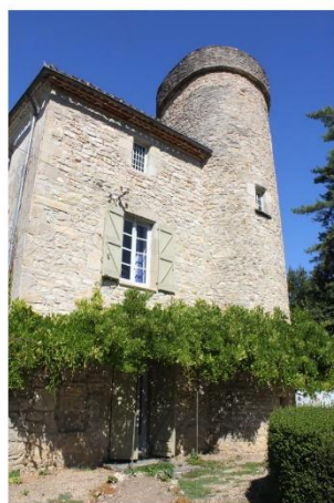
Fig. 8 - Détail de l'élévation sud et de la tour.
