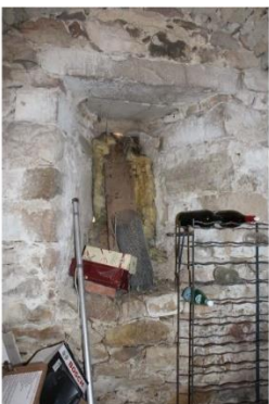
Fig. 22 - Tour ronde, baie du rez-de-chaussée.
