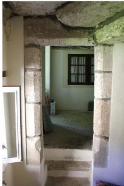
Fig. 32 - Porte extérieure de la tour ronde.
