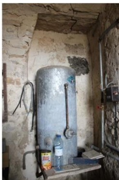
Fig. 23 - Tour ronde, rez-de-chaussée, ancien passage maintenant obturé.
