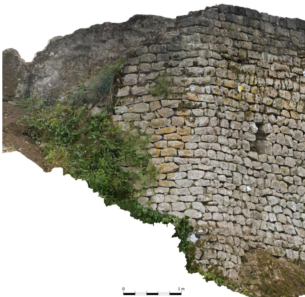
Fig. M7 en parement externe, aspect de l'angle arrondi, orthomosaïque de la photogrammétrie. Crédit F. Guillot
