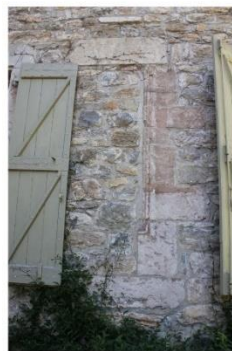
Fig. 54 - Partie d'un encadrement en remploi dans l'élévation sud du retour oriental.
