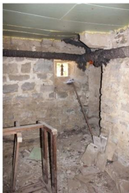
Fig. 17 - Détail de l'élévation intérieure du niveau de soubassement.
