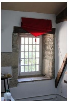
Fig. 52 - Emprise correspondant à une ancienne baie médiévale.
