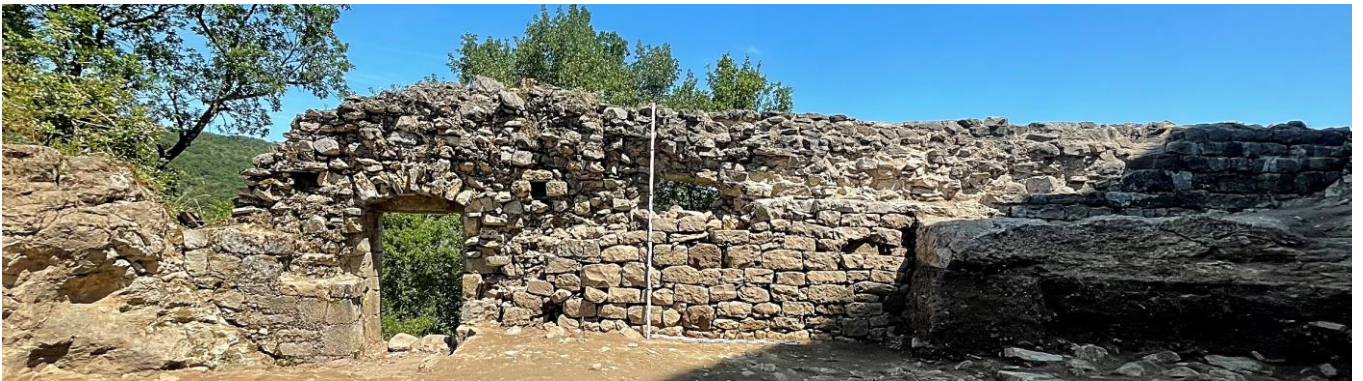
Fig. M7 en parement interne en fin de fouille. On note la même différence entre le mur de la courtine et celui de la poterne qu'en face externe. Crédit F. Guillot
