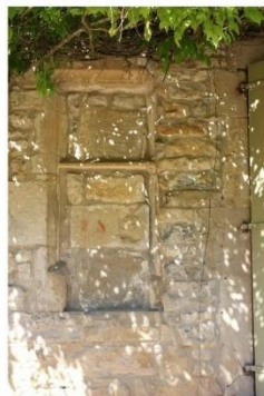
Fig. 42 - Croisée maintenant obturée dans l'élévation sud.
