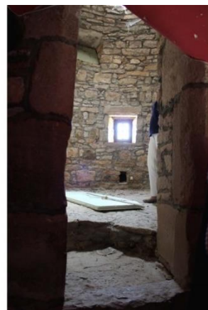
Fig. 36 - Entrée du dernier niveau de la tour ronde.
