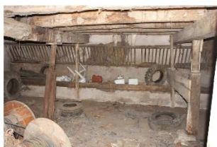
Fig. 61 - Bâtiment agricole, emplacement de l'étable.
