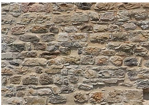
Fig. M37 parement externe partie basse
