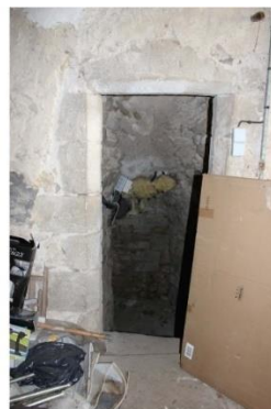
Fig. 24 - Tour ronde, porte du rez-de-chaussée, encadrement à large chanfrein et à base pyramidale.
