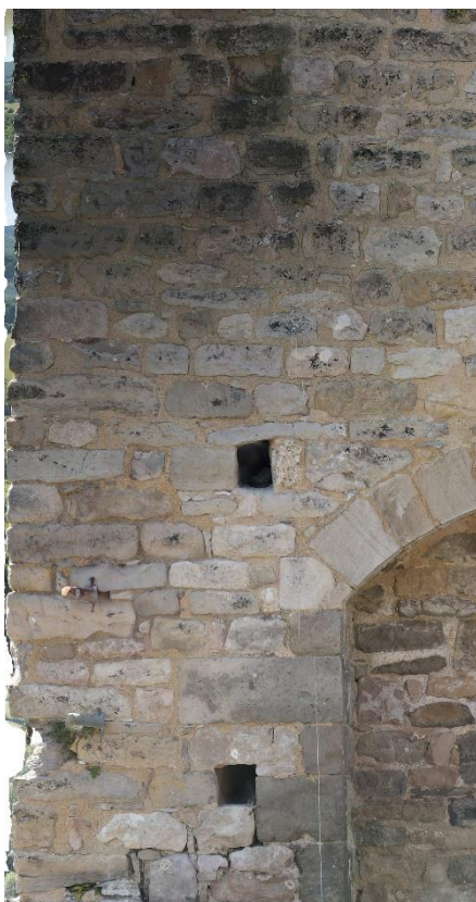
Fig. Encoches de la structure ajoutée contre le M40. En haut, encoche creusée de quelques centimètres dans le mur antérieur. Au milieu, ancien boulin rétréci. En bas, encoche façonnée. Cr. F. Guillot
