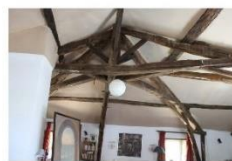
Fig. 51 - Extrémité nord, charpente de la croupe du corps de logis principal.
