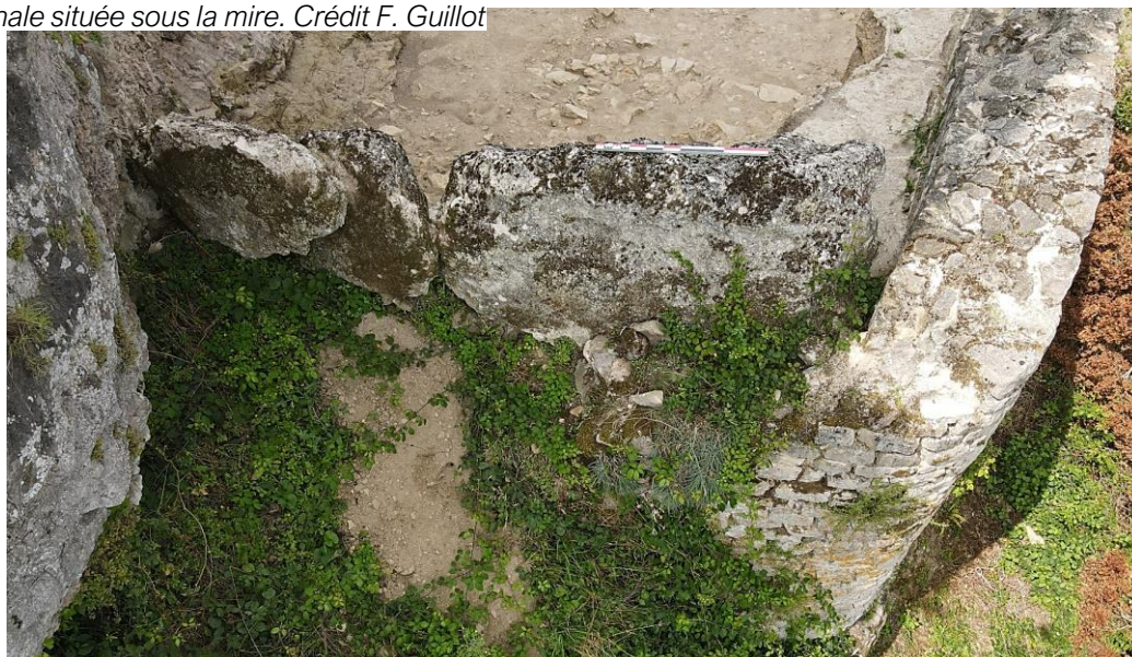
Fig. M82 parement externe ; notez l'encoche longitudinale située sous la mire. Crédit F. Guillot
