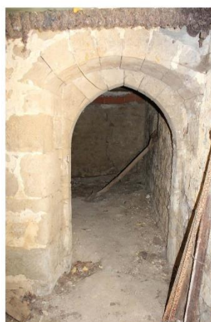
Fig. 15 - Intérieur de la porte en arc brisé du premier logis du château, avec système de fermeture avec barre coulissante.
