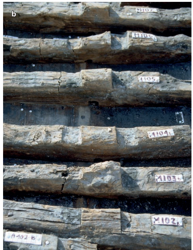
Fig. 97 – Toulon 3-4. Les membrures au niveau de la quille: a) vue depuis le nord-ouest; b) détail des entailles pour l'encastrement de deux carlingots latéraux (clichés CAV).
