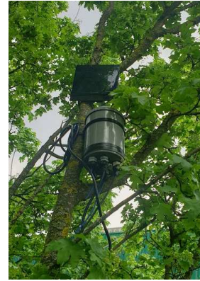
Système en place sur site
