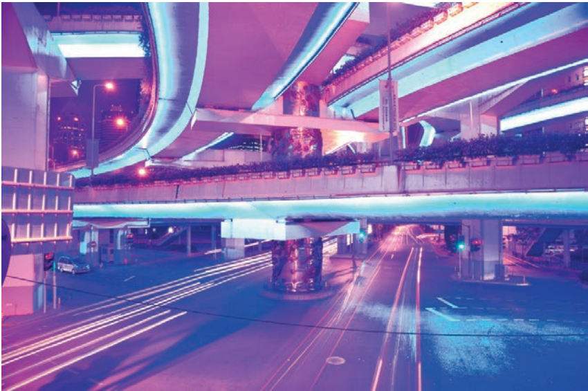
ILL. 21 — Le pilier orné de motifs de dragons qui soutient les voies rapides surélevées (© P. Gerold, avec son aimable autorisation) ( https://www.flickr.com/photos/paulgerold/14509071306/in/set-72157645424593235/ , consulté le 12/01/2015)
