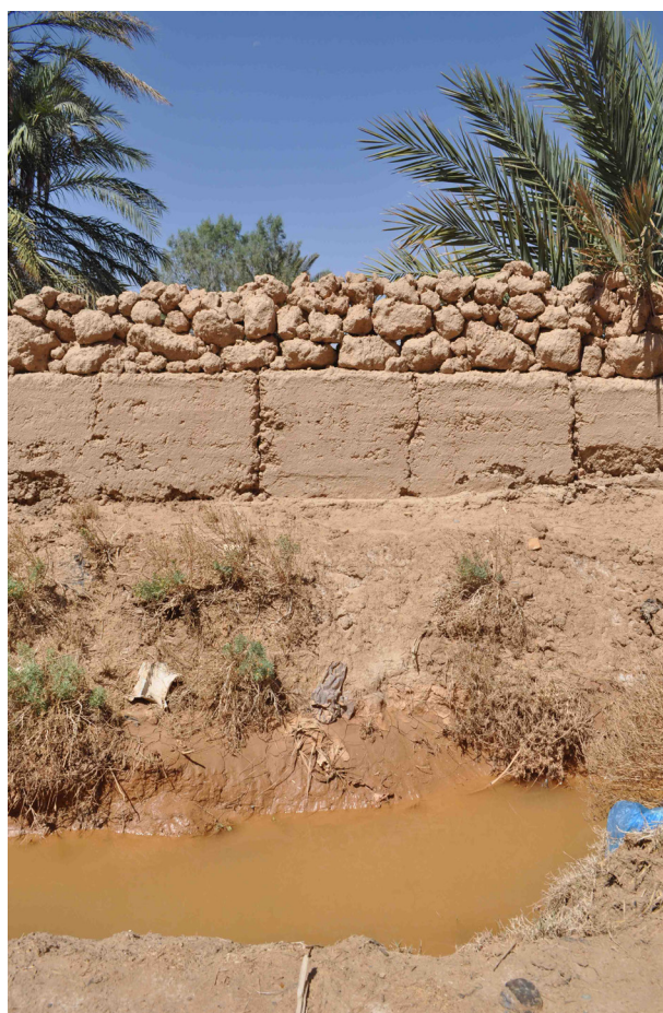
Fig. 15 – Exemple actuel d'un mur de clôture bâti en terre en lien avec un fossé dans la région de Rissani au Maroc (clichés : C.-A. de Chazelles)
