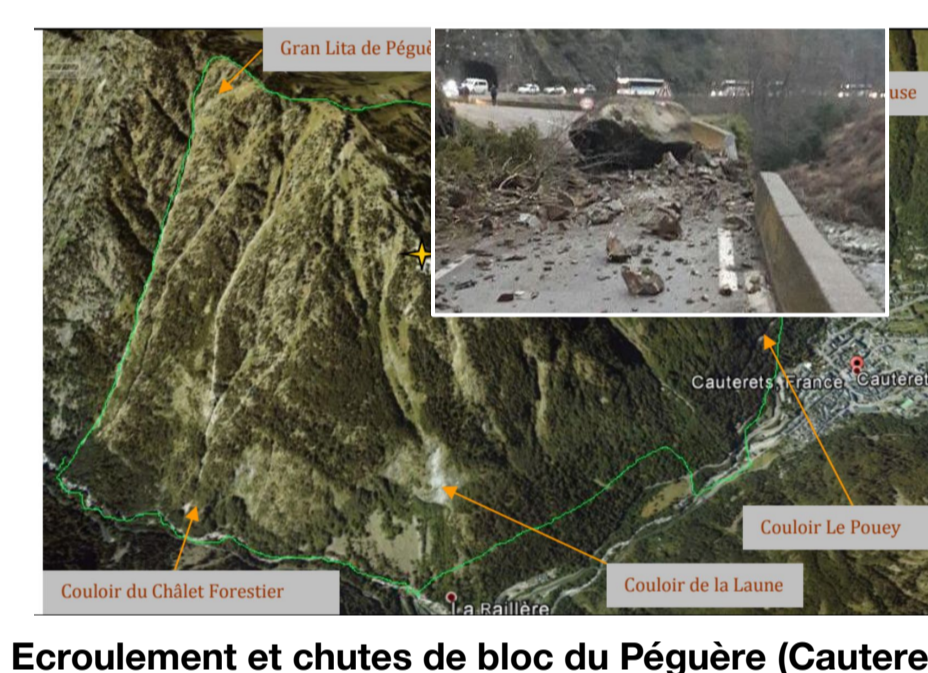
Eroulement et chutes de bloc du Peguère (Cauterets)
