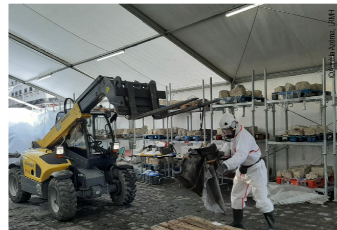
Inventaire des éléments métalliques sur le chantier.
