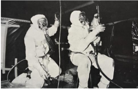
Figure 1 : Travaux au cœur du réacteur accidenté, ATEN, 1970
