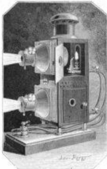
Fig. 6. Appareil de projection à lumière cathodique, préparé par Basile, destiné pour les cours.
