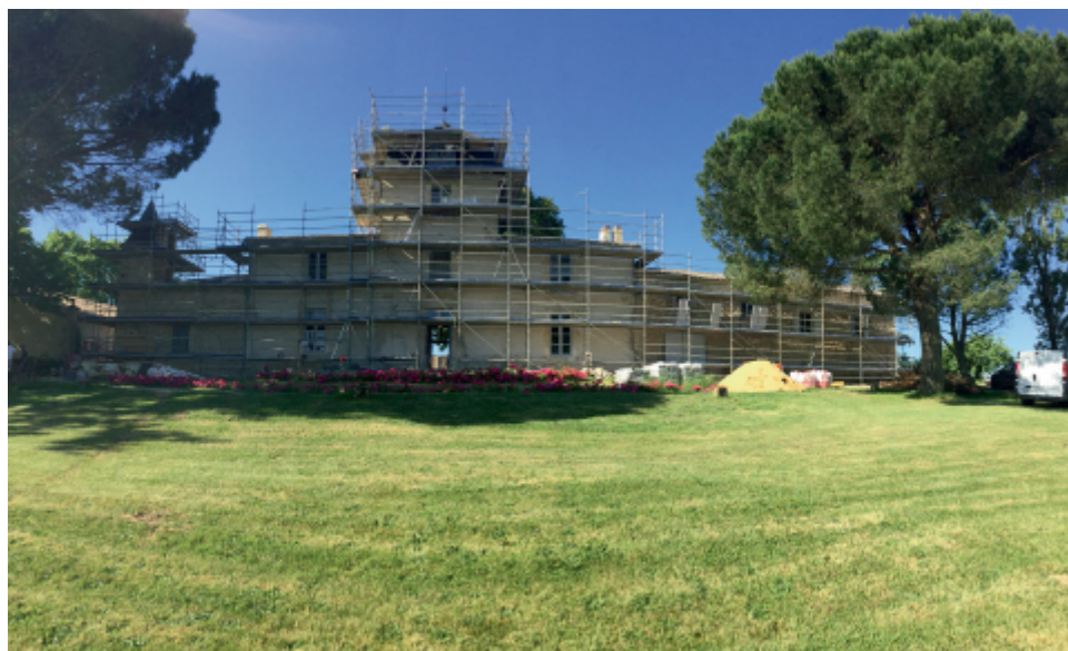
Figure 1. Chantier de restauration de la maison de François Mauriac, domaine de Malagar, Saint-Maixant (Gironde), juin 2020.
