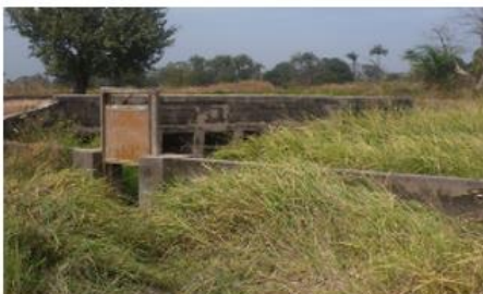
Photo 4 : L'état des infrastructures hydroagricoles dans la vallée de Badobar
