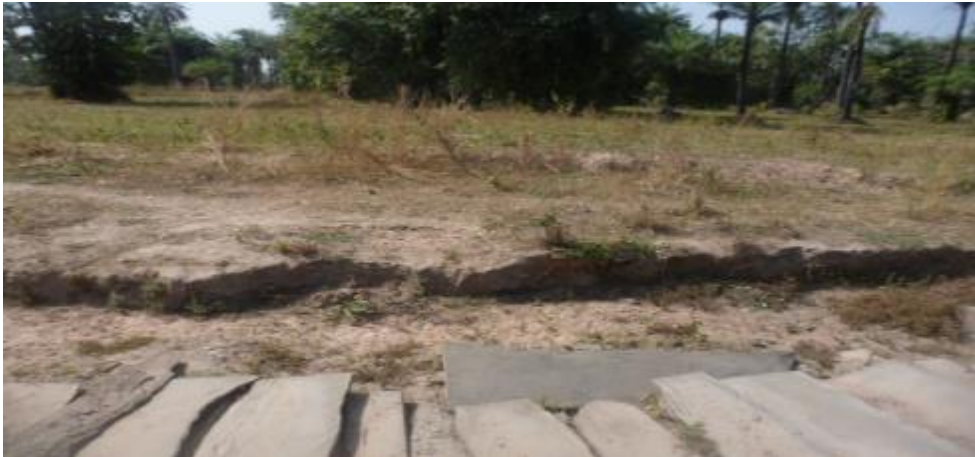
Photo 1 : Dégradation et effet du ravinement d'une partie de la vallée de Badobar
