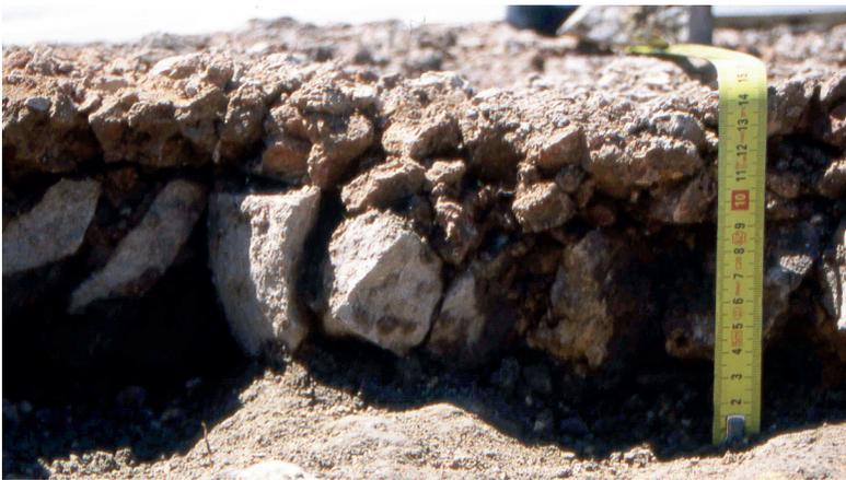
Fig. 4. Coupe du pavement : le *statumen* est composé de pierres irrégulières posées de chant (© ACRM/MDAA).
