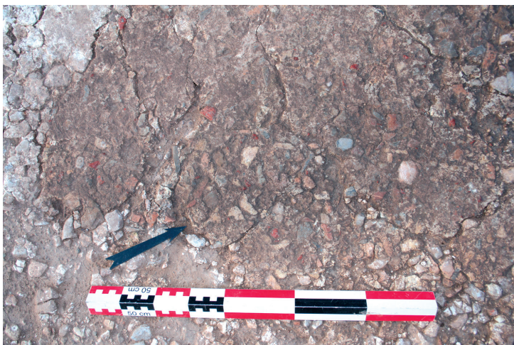
Fig. 11. Parking Aubenas, pièce 3 (SL2010), pavement en béton chargé de gros éléments de terre cuite et de calcaire (Service Archéologie et Patrimoine de la Ville de Fréjus).
