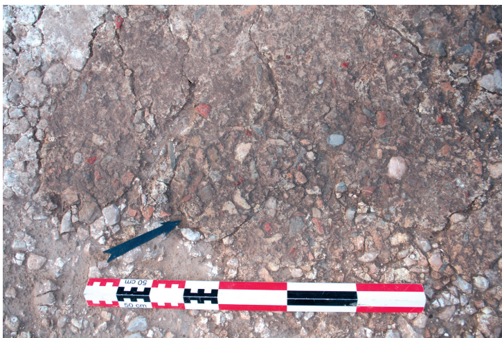
Fig. 11. Parking Aubenas, pièce 3 (SL2010), pavé en béton chargé de gros éléments de terre cuite et de calcaire (Service Archéologie et Patrimoine de la Ville de Fréjus).
