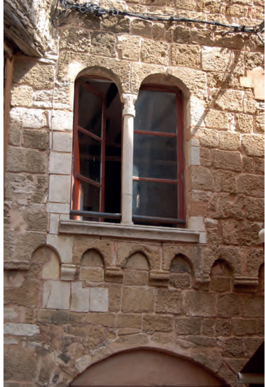
Fenêtre géminée avec une bande arcaturée reposant sur des modillons moulurés (crédit É. Tomas)
