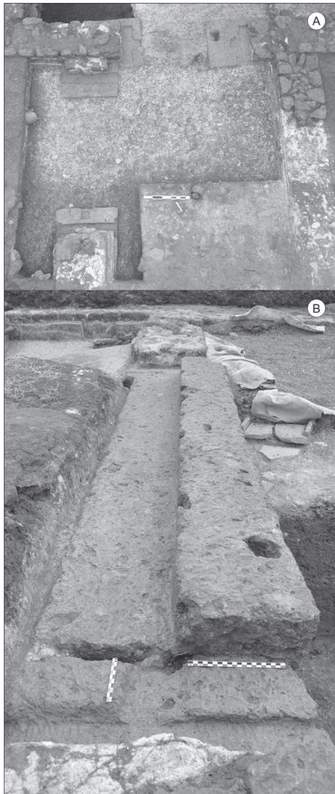
Fig. 13 – A, sols et seuils entre trois pièces du deuxième corps de bâtiment du Grand Villard (cliché : N. Morelle) ; B, seuil à pas étroit (cliché : M. Grall).
