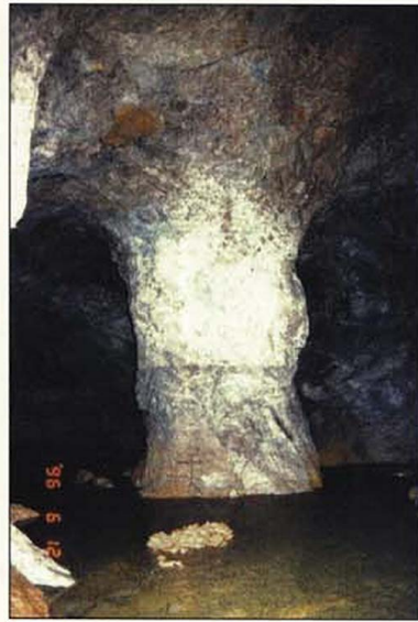
Figure 6 – Vues d'un même pilier dans la carrière abandonnée de Rocquevaire (Bouches-du-Rhône) avec deux niveaux d'envoyage différent (en 1996 à droite et en 2010 ci-dessous). Les observations faites depuis une vingtaine d'années ne montrent pas d'évolutions significatives liées à la dissolution.
