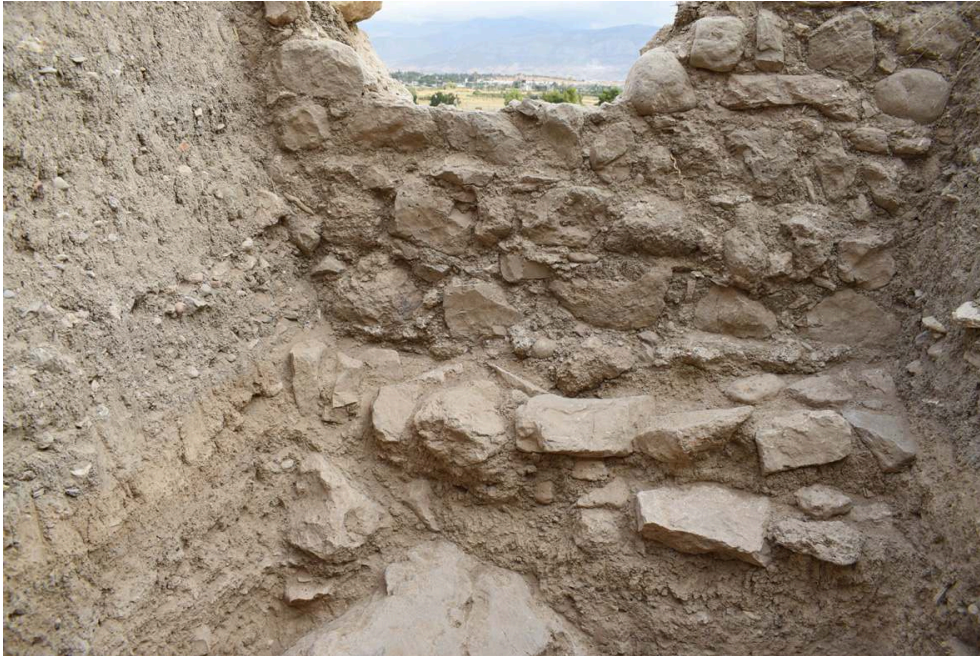
Fig. 6. Fondation des murs USM PK2 et USM 1025.
