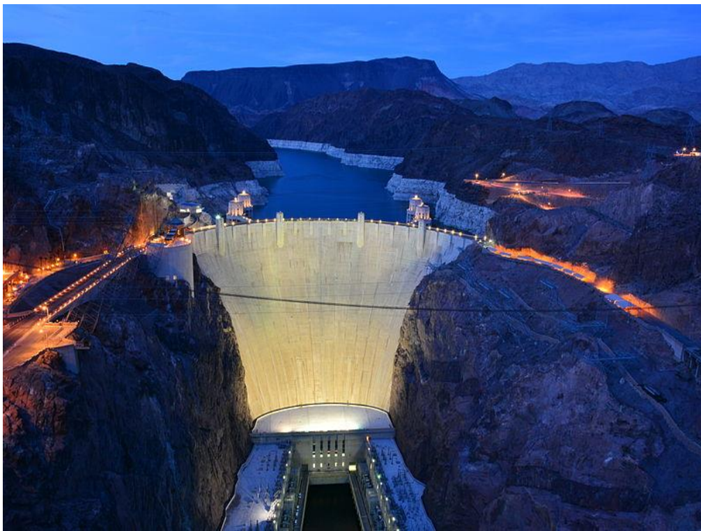
Barrage Hoover (Colorado)
