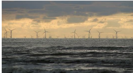
Parc éolien off-shore, mer du nord
