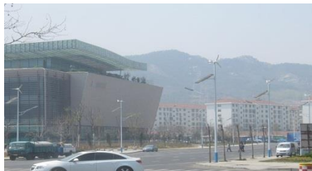
Réverbères alimentés par un mix solaire-éolien / Weihai (Chine)
