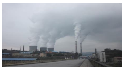
Centrale thermique à Lengshuijiang (Hunan)
