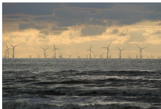
Parc éolien off-shore, mer du nord
