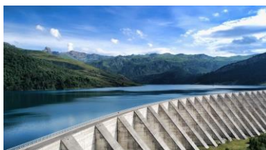
Barrage de Roselend (Savoie)
