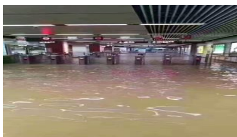
Station de métro en Chine (ici Shenzhen, cité de 13 millions d'habitants)
