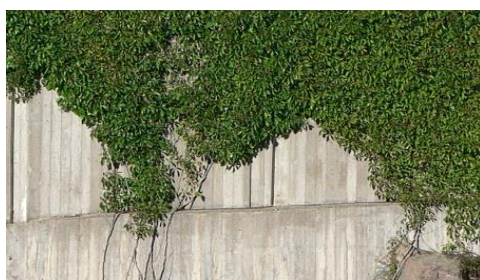
Mur anti bruit en béton
