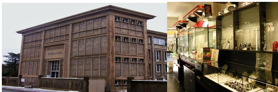
Usine des horlogeries Dodane (Besançon).
