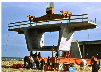
Un voussoir du pont de l'île de Ré
