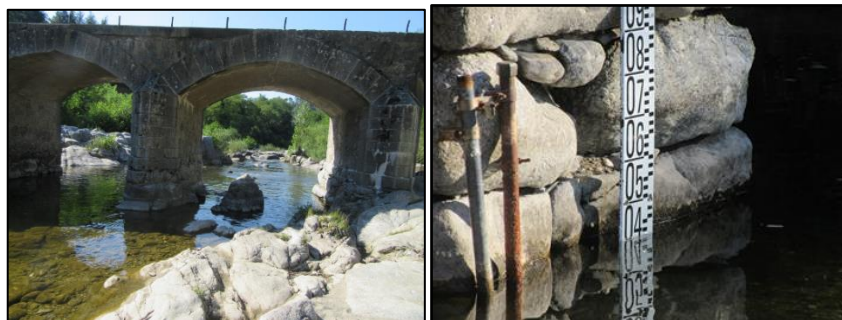
FIG.55 — STATION DE SAINT-JEAN DU GARD — À GAUCHE, GARDON DE SAINT-JEAN AU PONT DE CAMBONÉRAL, VU DE L'AMONT — À DROITE, ÉCHELLE AU PLUS BAS DE L'ÉTIAGE, LE 9 SEPTEMBRE 2019
