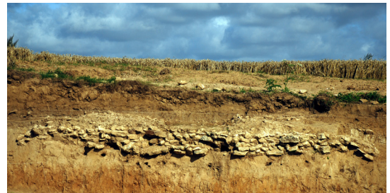
À Commeny dans le Val d'Oise, l'étude de la voie romaine a révélé son mode de construction propre à cet endroit du Vexin français. Au I er siècle, dans une tranchée préalablement creusée, le sol a été nivelé et aménagé avec de la chaux, puis des talus ont été créés sur les côtés. Ensuite, le radier qui constituait l'assise de la voie, large de 6,80 m a été composé avec de gros blocs de calcaire et de grès. Un premier niveau de circulation formé de pierres calcaires liées par de la chaux, présentait des ornières creusées par les chariots
