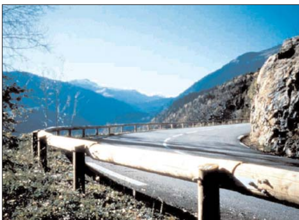
Glissière de sécurité routière
