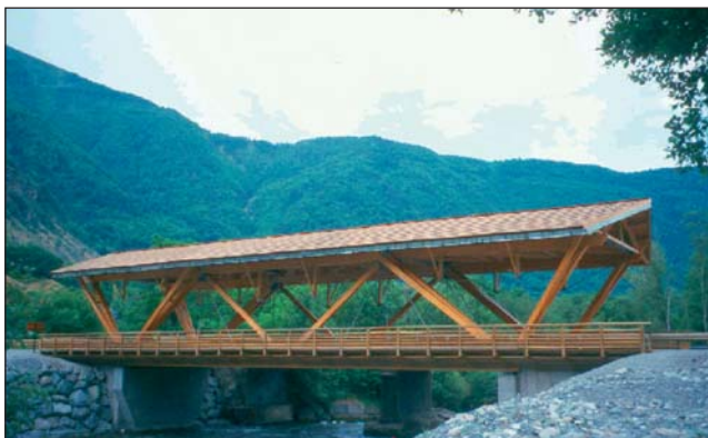
Entreprise : SDCC / Bureau d'Étude
