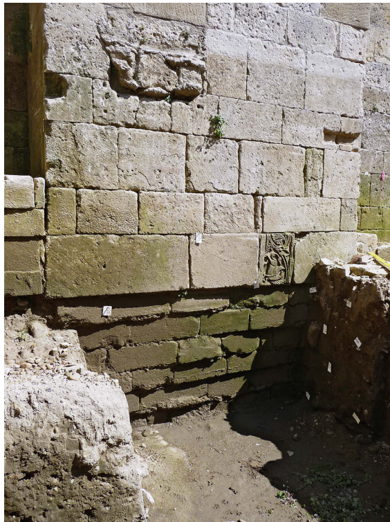
6 Fundamente des ersten Westjochs der südlichen Langhausmauer (2015).
