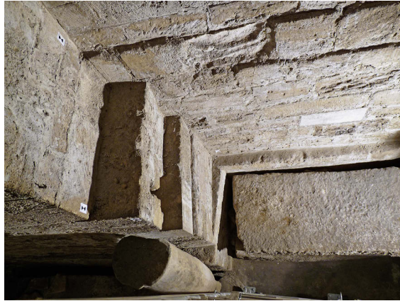
5 Unterkirche, Fluchtkorrekturen am südöstlichen Wandpfeiler (2010).
