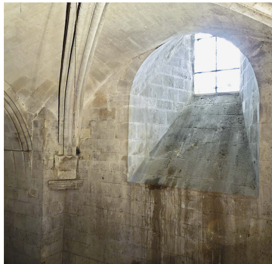
8 Unterkirche, Anfang des Kreuzrippengewölbes im Westjoch des südlichen Seitenschiffs (2010).
