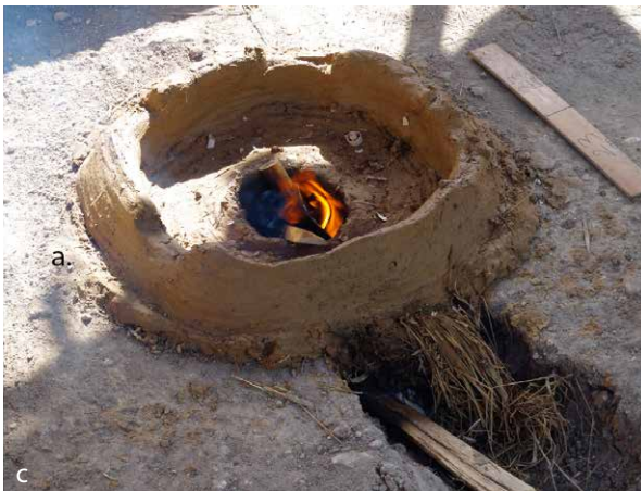
Figure 102 : Construction et utilisation d'une reconstitution d'un four de verrier à Samara. a. Après le creusement de l'alandier et du cendrier, la sole du four est posée. b. La margelle sur laquelle reposeront les creusets est progressivement avancée au-dessus du cendrier. c. Les parois du four sont progressivement montées en prenant en compte la position des ouvreaux. La base du four est séchée par le feu. d. Les ouvreaux sont fermés avant la fermeture de la voûte du four. e. Après séchage et temps de chauffe, le four peut être utilisé. Sur ce four, un cendrier destiné au recuit des pièces fut construit plus tard au-dessus du four. (Photos a. b. et c. Yves le Bechenec).
